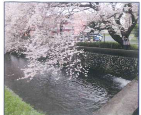
拝島駅北口殿ヶ谷分水付近
